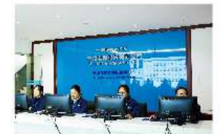
申龙电梯数据中心
